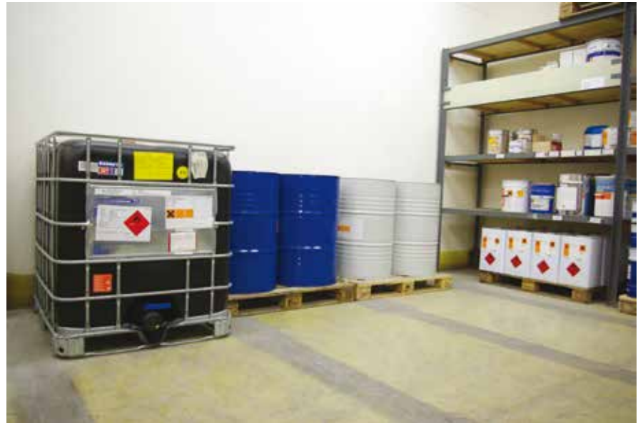
Abb.: GFK-Raumauskleidung eines Chemikalienlagers
