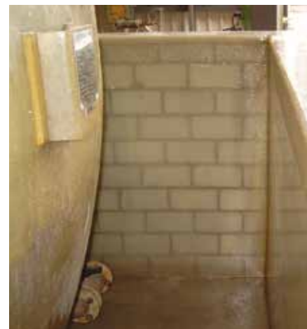
Abb.: GFK-Auskleidung für die Abmauerung eines Altöltanks
